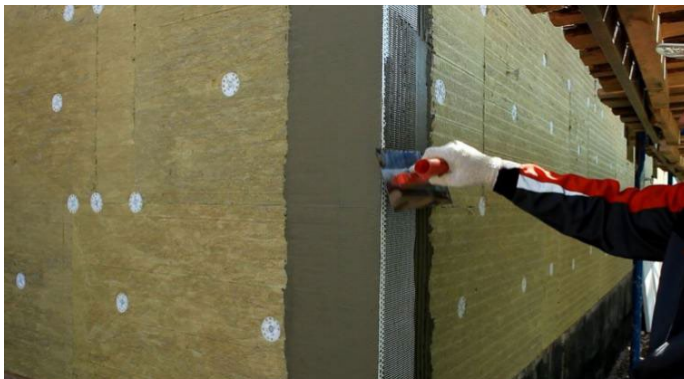
Рис. 15. Установка усиливающих профилей на углах здания
