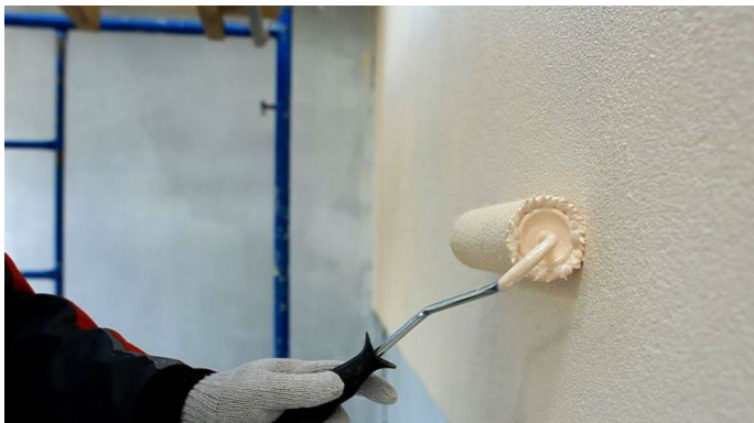
Рис. 19. Нанесение краски на поверхность фасада
