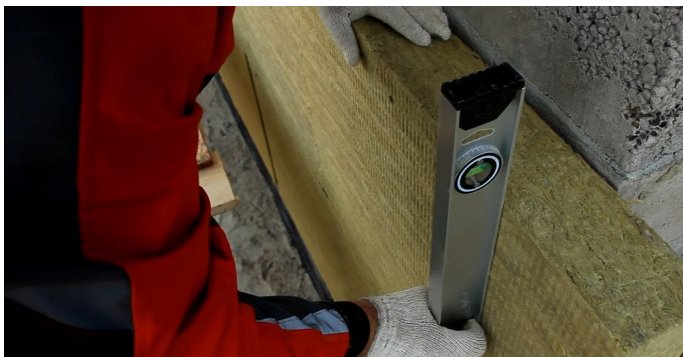
Рис. 8. Приклейка плиты тепло-, звукоизоляции к стене
