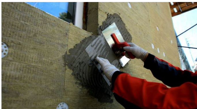
Рис. 14 б. Установка усиливающих элементов из армирующей сетки вокруг дверных и оконных проемов
