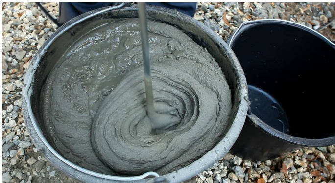
Рис. 3. Замешивание клея для приклейки теплоизоляции
