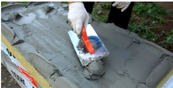
Рис. 6. Нанесение клея на плиту контурно-маячковым методом приклейки
