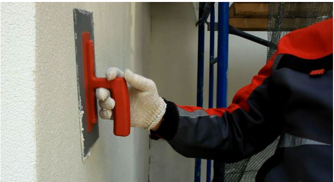
Рис. 18. Нанесение декоративного слоя штукатурки
