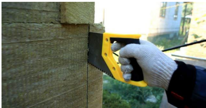
Рис. 10. Зубчатая перевязка плит на наружных углах здания
