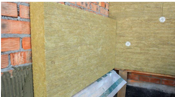
Рис. 2. Установка опорного профиля для первого ряда теплоизоляции б) с применением деревянного бруса
