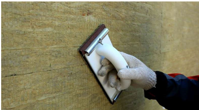
Рис. 12. Шлифовка стыков плит теплоизоляции наждачной бумагой
