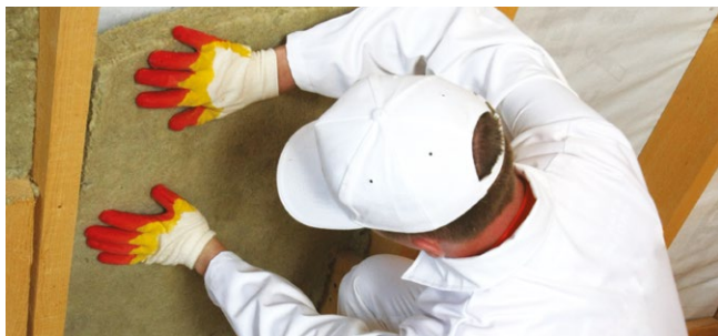
Рис. 4.3.6. Монтаж теплоизоляции враспор между стропилами
