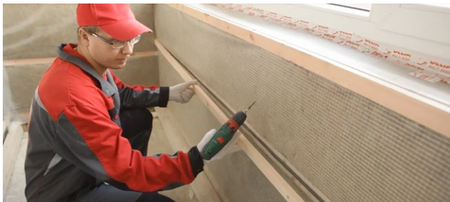
Рис. 7.47. Монтаж контррейки
