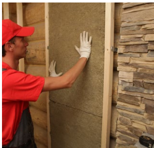
Рис. 6.14. Укладка плит теплоизоляции
