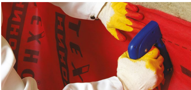
Рис. 4.5. Укладка и фиксация пароизоляционной пленки
