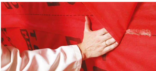
Рис. 4.6. Проклейка стыков пароизоляционной пленки
