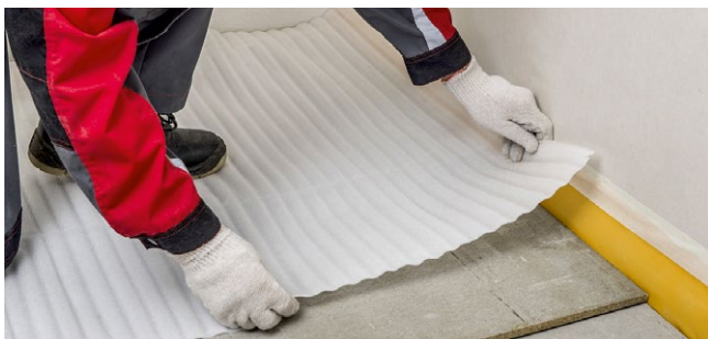
Рис. 5.14. Укладка подложки под финишное покрытие пола
