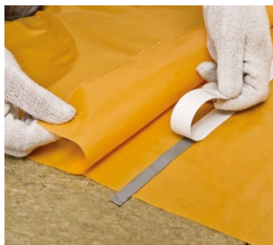
Рис. 5.3. Монтаж и проклейка нахлестов пароизоляционной пленки
