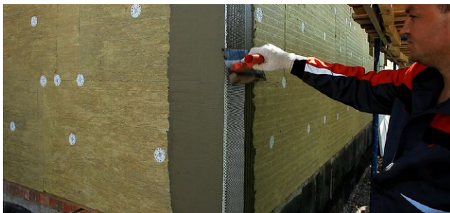
Рис. 7.37. Установка усиливающих профилей на углах здания
