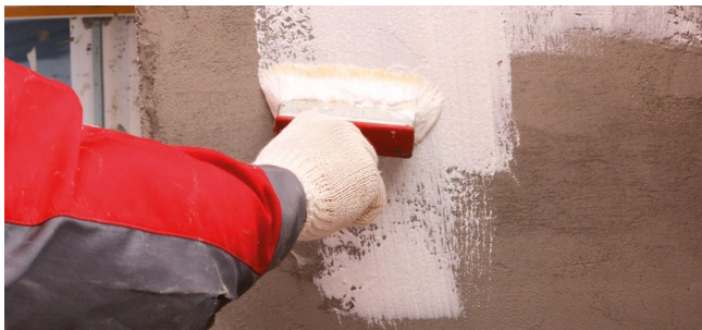
Рис. 7.40. Нанесение кварцевой грунтовки на поверхность базового штукатурного слоя
