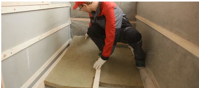
Рис. 7.50. Укладка теплоизоляционных плит
