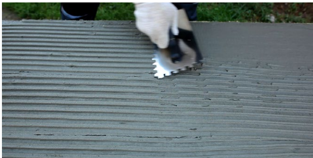
Рис. 7.28. Нанесение клеевого состава на плиту сплошным методом приклейки
