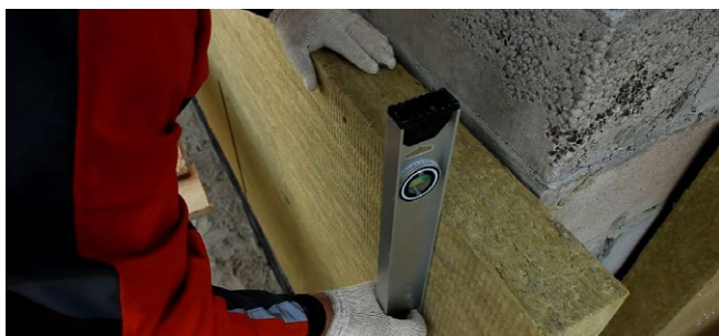
Рис. 7.31. Приклейка плиты тепло-, звукоизоляции к стене
