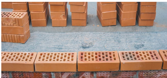
Рис. 7.8. Гидроизоляционная отсечка
