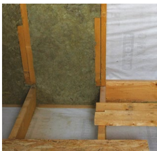
Рис. 4.2. Подготовленная система для дальнейшего монтажа теплоизоляции
