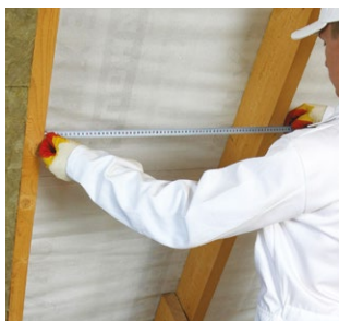
Рис. 4.2. Подготовленная система для дальнейшего монтажа теплоизоляции
