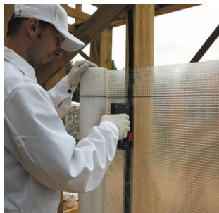
Рис. 7.20. Монтаж пароизоляционной пленки
