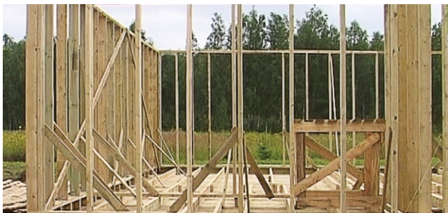
Рис. 7.19. Установка деревянного каркаса
