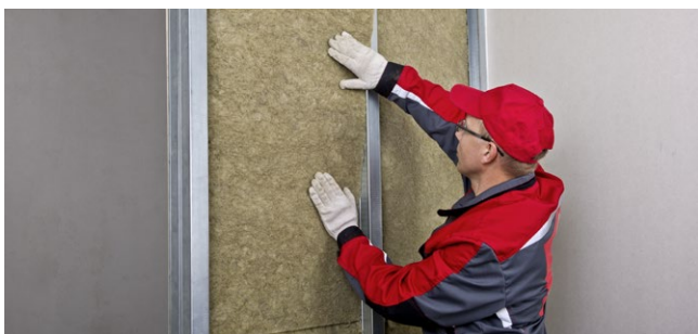
Рис. 6.6. Укладка плит ТЕХНОАКУСТИК
