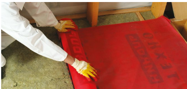
Рис. 4.12. Монтаж ветро-, влагозащитной мембраны
