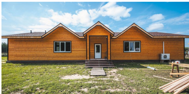
Рис. 7.23.б. Монтаж облицовочного материала
