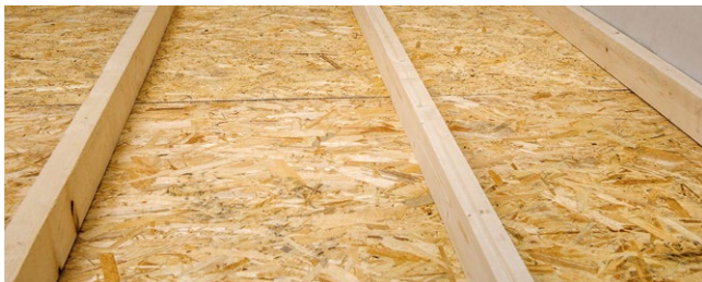
Рис. 5.1. Подшивка лаг снизу
