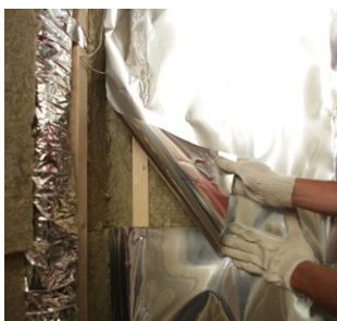
Рис. 6.16. Проклейка стыков пароизоляции
