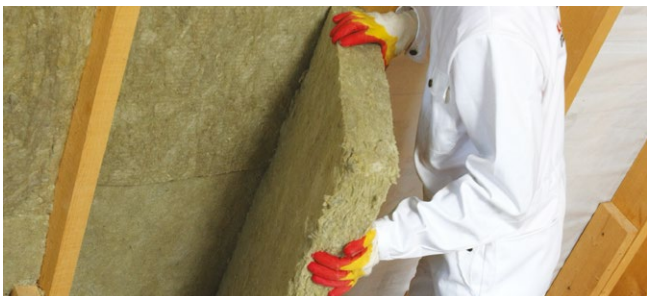
Рис. 4.3.а. Монтаж теплоизоляции враспор между стропилами
