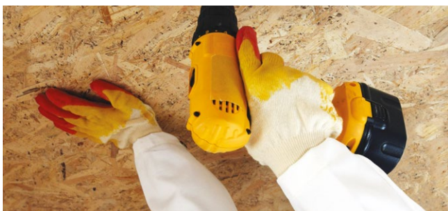
Рис. 4.10. Подшивка потолка листами ОСП
