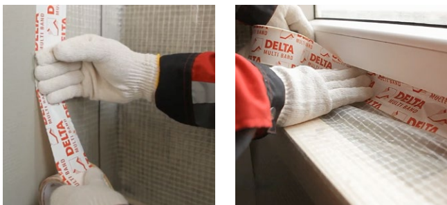
Рис. 7.53. Проклейка примыканий пароизоляции к стенам и окну
