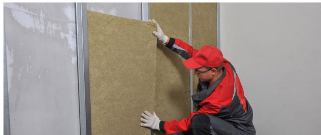
Рис. 6.11. Монтаж тепло-, звукоизоляционных плит
