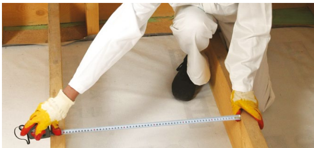
Рис. 4.9. Смонтированная пароизоляционная пленка
