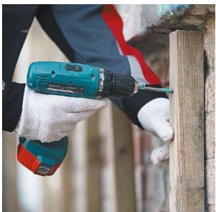
Рис. 71. Крепление вертикальных стоек деревянного каркаса
