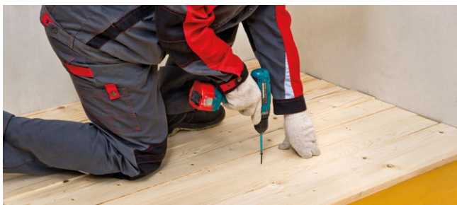
Рис. 5.4.а. Монтаж чернового пола
