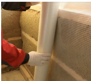
Рис. 7.46. Монтаж пароизоляции
