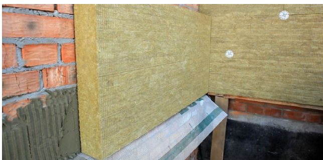
Рис. 7.26.б. Установка опорного профиля для первого ряда теплоизоляции с применением деревянного бруса
