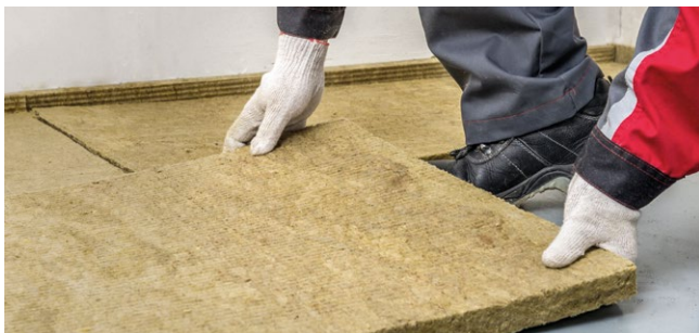
Рис. 5.8. Укладка плит ТЕХНОФЛОР СТАНДАРТ
