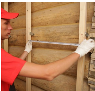
Рис. 6.13. Установка каркаса под теплоизоляцию
