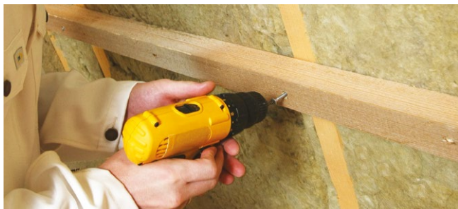
Рис. 4.4.а. Укладка второго слоя теплоизоляции
