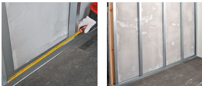
Рис. 6.10. Установка направляющего и стоечного профилей
