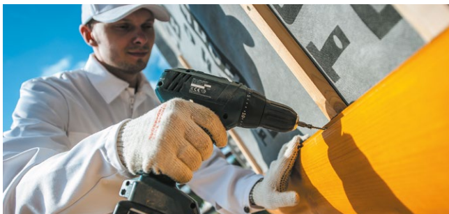
Рис. 7.23.а. Монтаж облицовочного материала
