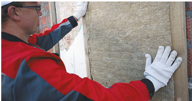
Рис. 7.2. Монтаж теплоизоляционных плит в вертикальный каркас
