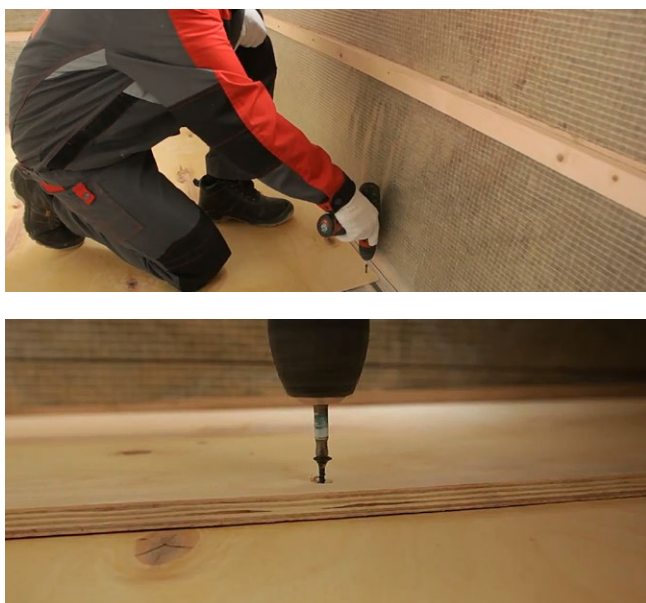
Рис. 7.54. Установка покрытия пола
