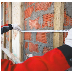
Рис. 71. Крепление вертикальных стоек деревянного каркаса
