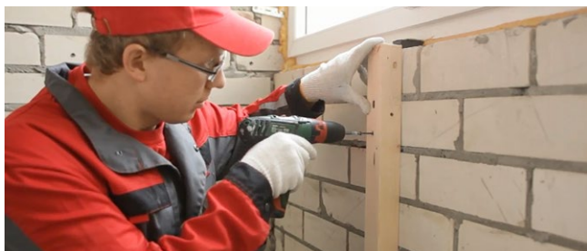
Рис. 7.42. Установка вертикального каркаса под теплоизоляцию
