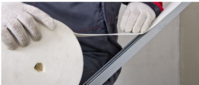
Рис. 6.9. Приклейка уплотнительной ленты к профилям
