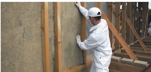
Рис. 7.21. Монтаж теплоизоляционных плит
