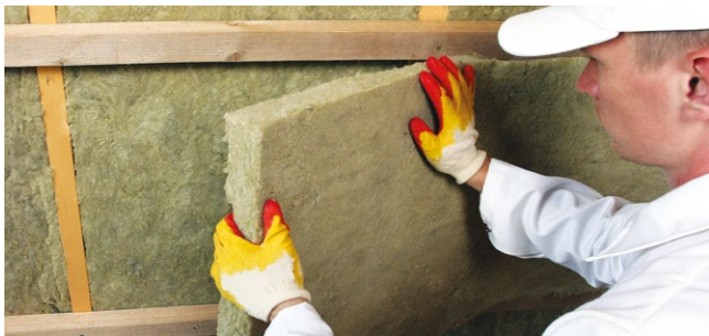
Рис. 4.4.б. Укладка второго слоя теплоизоляции
