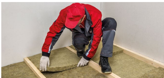
Рис. 5.2. Монтаж теплоизоляции враспор между лагами
