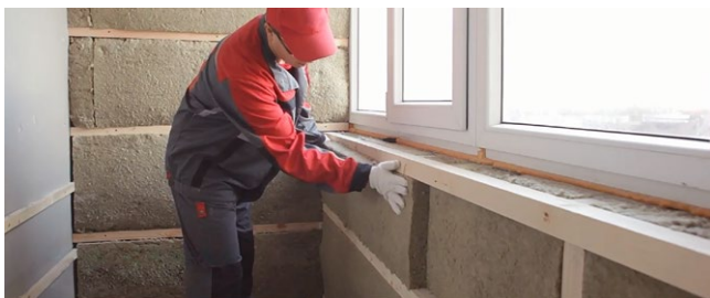
Рис. 7.45. Укладка плит теплоизоляции второго слоя
