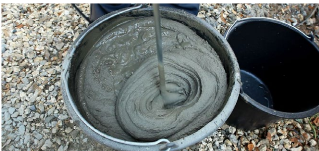
Рис. 7.27. Замешивание клея для приклейки теплоизоляции
