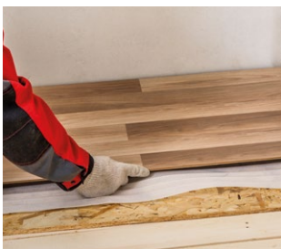
Рис. 5.5. Монтаж чистового покрытия
