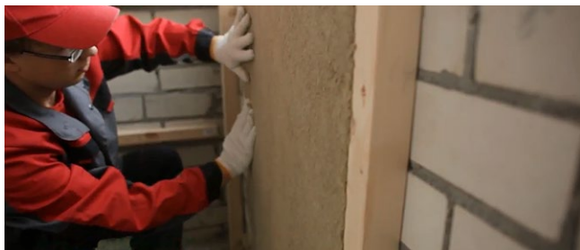
Рис. 7.43. Укладка плит теплоизоляции первого слоя
