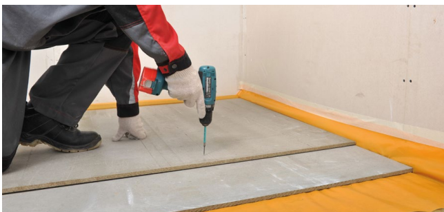
Рис. 5.11. Устройство сборной стяжки
