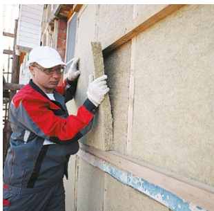
Рис. 7.4. Монтаж теплоизоляционных плит в горизонтальный каркас
