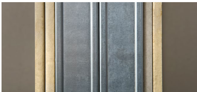
Рис. 6.7. Обшивка второй стороны перегородки листами ГКЛ
