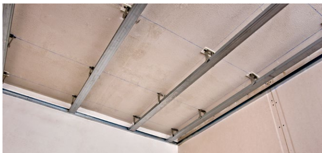
Рис. 5.20. Установка подвесов и потолочного профиля
