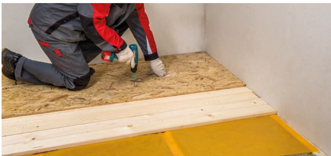
Рис. 5.4.б. Монтаж чернового пола
