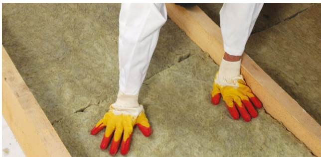
Рис. 4.11. Монтаж теплоизоляции между балками
