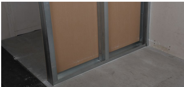
Рис. 6.5. Обшивка первой стороны листом ГКЛ
