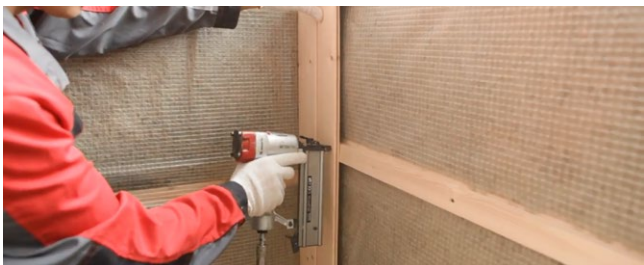
Рис. 7.48. Устройство внутренней обшивки
