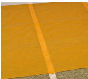
Рис. 5.3. Монтаж и проклейка нахлестов пароизоляционной пленки
