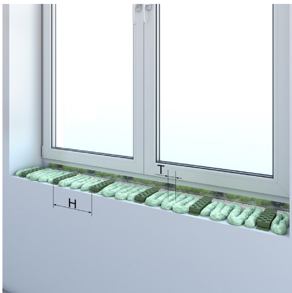
Рисунок 11.2 – Поверхность оконного проёма перед установкой подоконника.
