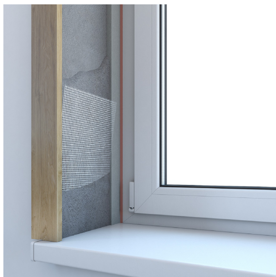
Рисунок 12.1 – Нанесение первого, нижнего слоя штукатурного раствора. Утапливание армирующей стеклосетки в нижнем слое
