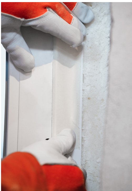
Рисунок 9.5 – Оклейка поверхности оконного блока малярным скотчем
