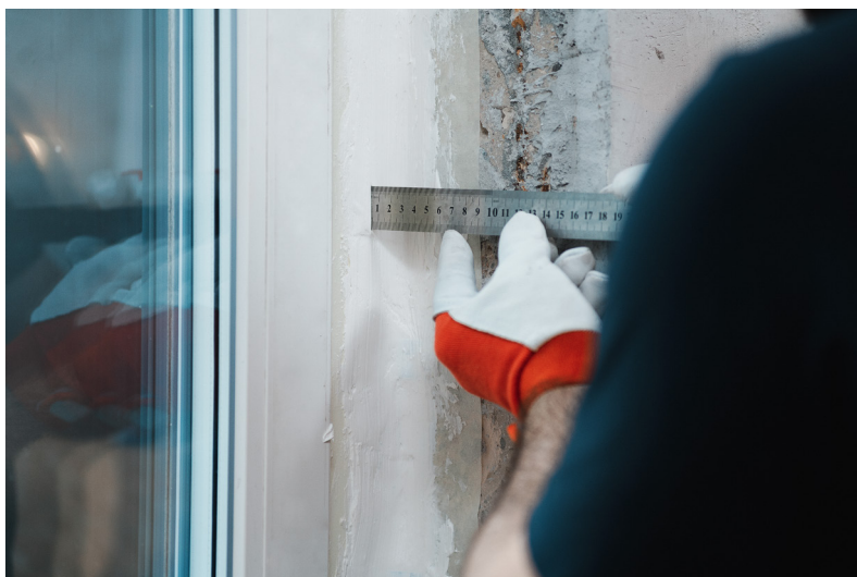
Рисунок 9.7 – Контроль толщины слоя герметика в не отверждённом состоянии
