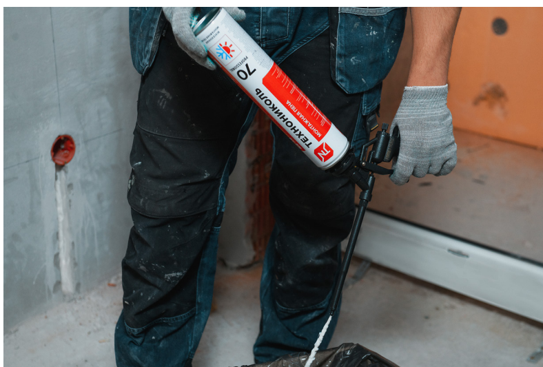
Рисунок 8.3 – Стравливание монтажной пены в контейнер перед началом работ
