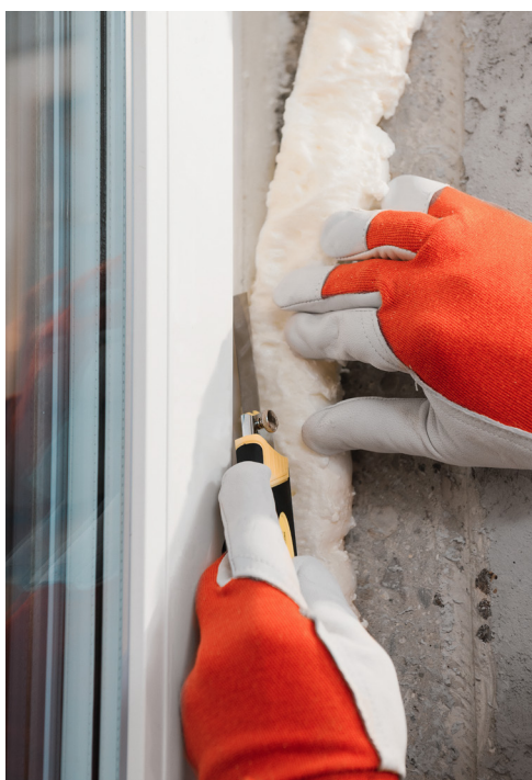
Рисунок 9.7 – Контроль толщины слоя герметика в не отверждённом состоянии
