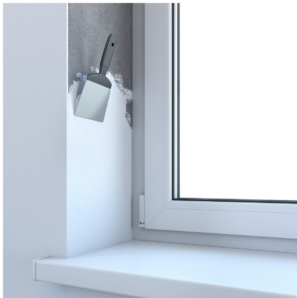
Рисунок 12.3 – Нанесение шпаклёвки на поверхность штукатурного откоса
