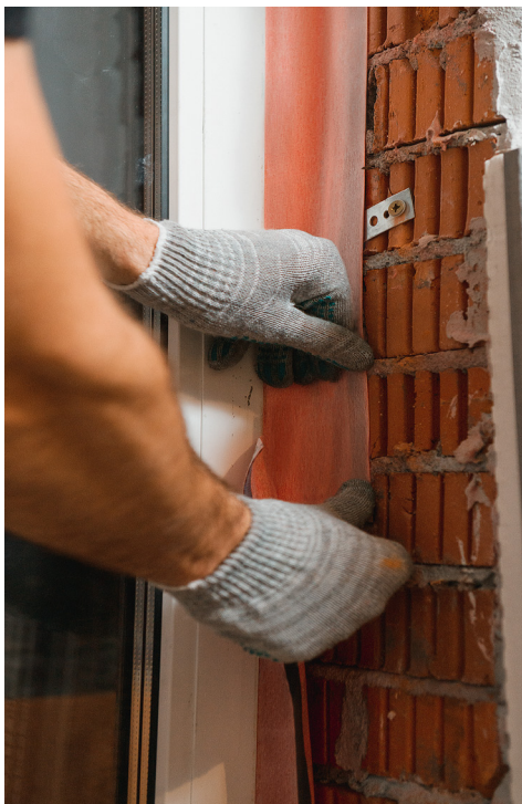
Рисунок 9.1 – Приклейка пароизоляционной ленты к стеновому проёму
