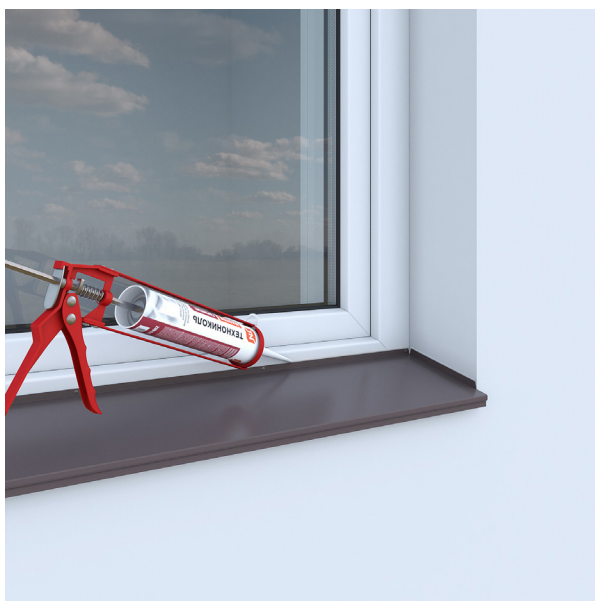
Рисунок 10.2 – Герметизация стыков примыкания оконного отлива к стене
