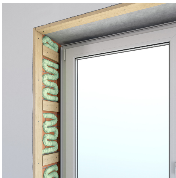
Рисунок 12.6 – Крепление на поверхности откоса вкладышей жёсткости. Нанесение клей-пены
