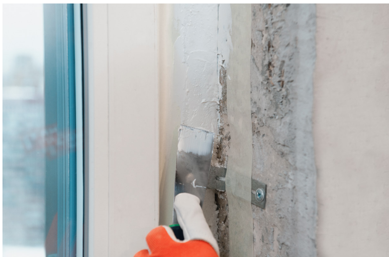
Рисунок 9.6 – Нанесение герметика ТЕХНОНИКОЛЬ пароизоляционного акрилового (внутреннего Б) на внутреннюю поверхность монтажного шва
