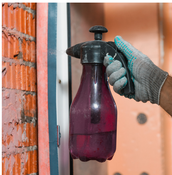
Рисунок 8.1 – Увлажнение поверхности оконного проёма перед заполнением шва монтажной пеной
