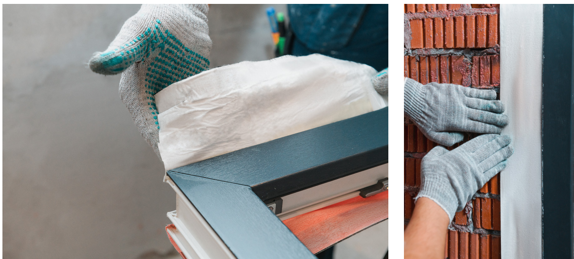
Рисунок 7.3 – Приклейка ленты паропроницаемой диффузионной к торцу оконного блока (слева) и к стеновому проёму (справа)
