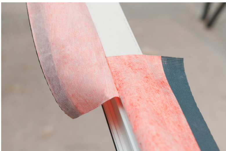
Рисунок 9.3 – Соединение двух отрезков паропроницаемой ленты на линейном участке внахлѣст
