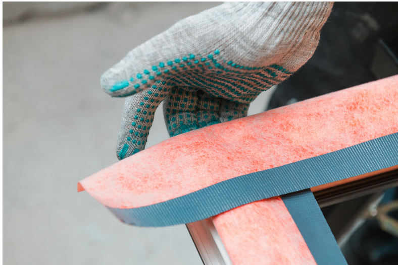
Рисунок 9.2 – Пример проклейки угла оконного блока пароизоляционной лентой
