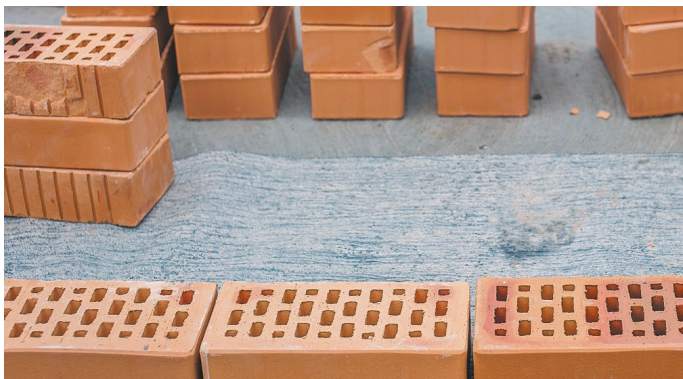
Рис. 7. Гидроизоляционная отсечка
