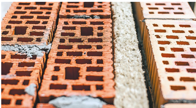
Рис. 11. Монтаж плит теплоизоляции
