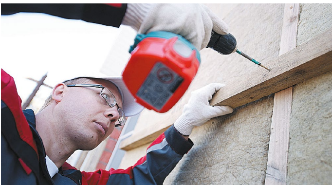
Рис. 3. Установка горизонтального каркаса
