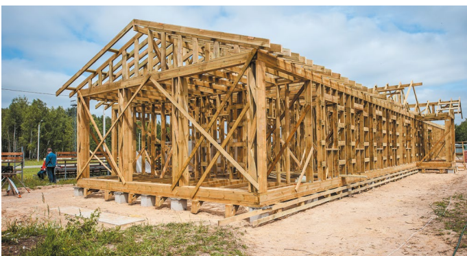
Рис. 18. Установка деревянного каркаса
