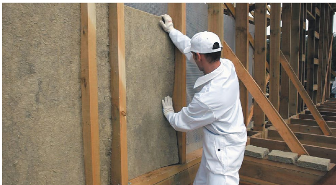
Рис. 20. Монтаж теплоизоляционных плит
