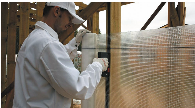
Рис. 19. Монтаж пароизоляционной пленки
