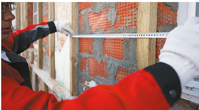
Рис. 1. Крепление вертикальных стоек деревянного каркаса
