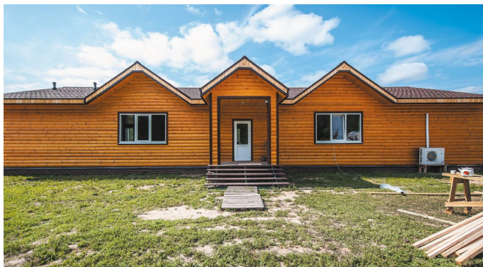
Рис. 22. Монтаж облицовочного материала
