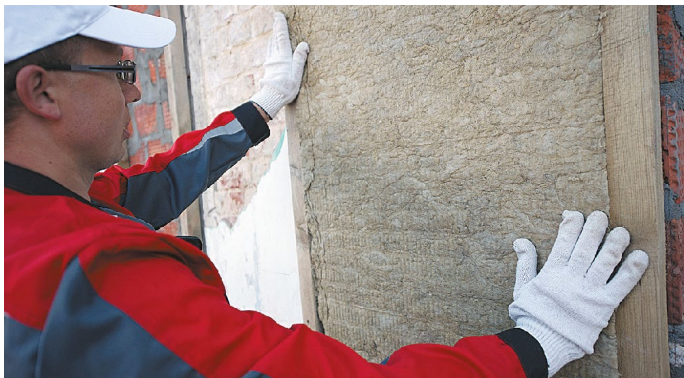
Рис. 2. Монтаж теплоизоляционных плит в вертикальный каркас
