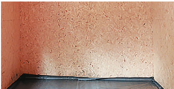
Рис. 23. Обшивка внутренней поверхности стен
