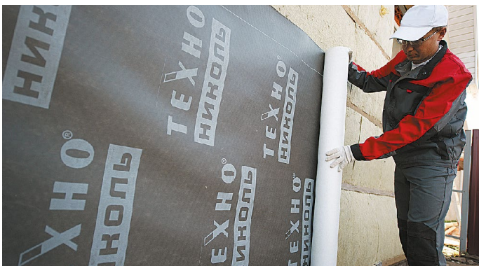
Рис. 5 а. Монтаж ветро-, влагозащитной мембраны
